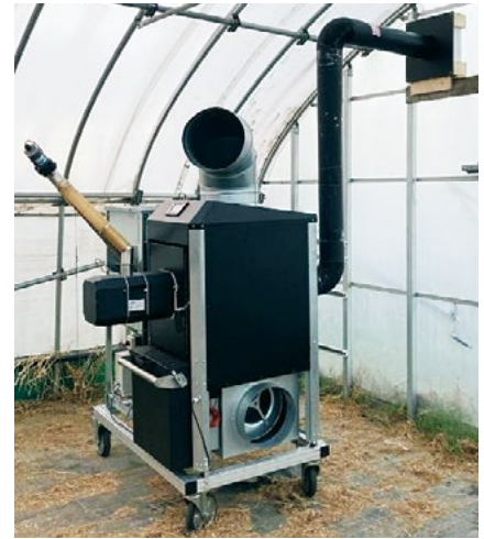
Ventura36CHBCによる籾殻燃焼の様子 (バイオマスバーナー吐出口付近)
